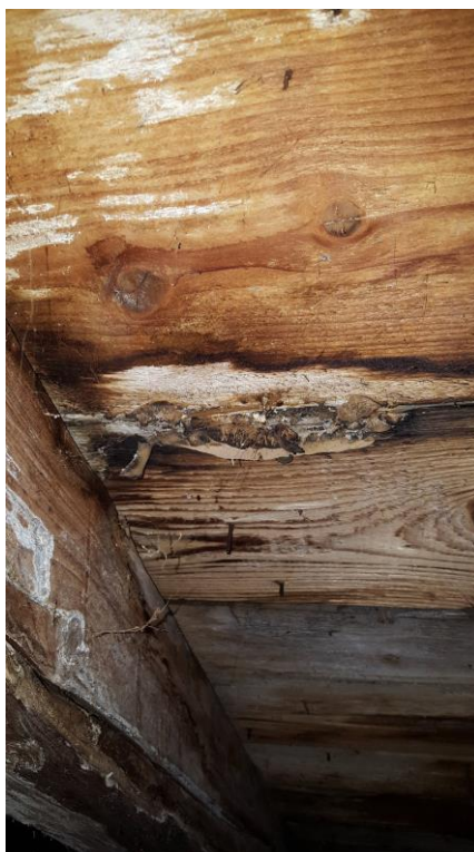
Č.31 – poškození zatékáním srážkové vody, dřevokaznými houbami, vlhkostí obsaženou v dřevní hmotě
