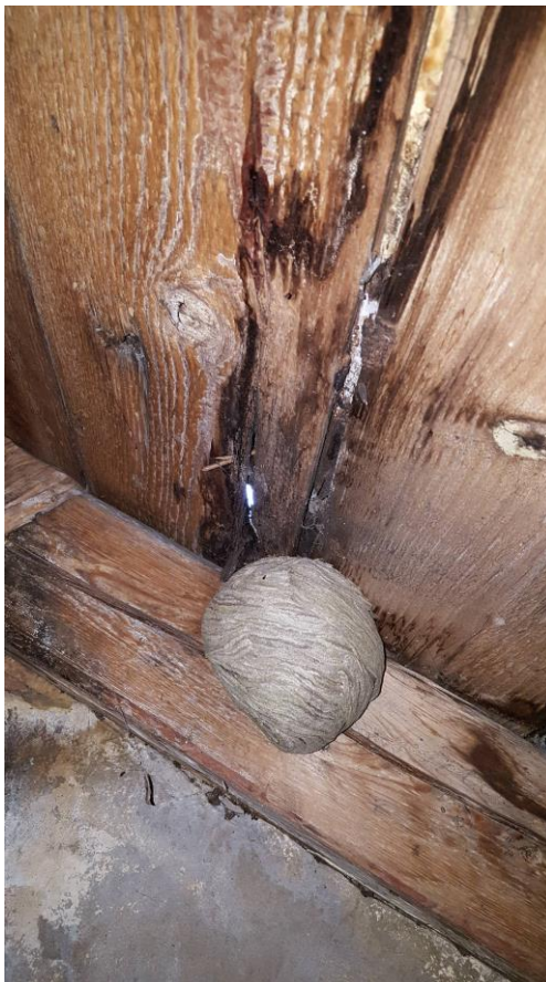
Č.1 – poškození zatékáním srážkové vody, hmyzem
