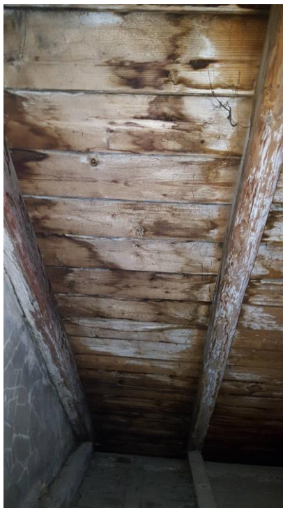
Č.2 – poškození zatékáním srážkové vody, plísní
