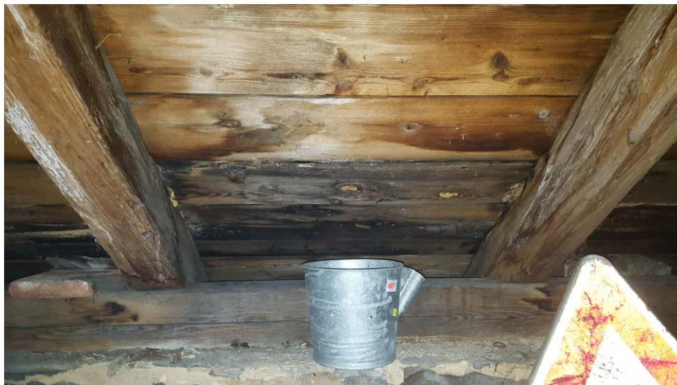
Č.55 – poškození zatékáním srážkových vod, dřevokaznou houbou
