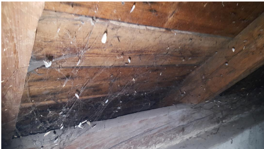
Č.13 – poškození zatékáním srážkové vody (hmyz nakažený spory dřevokazných hub)
