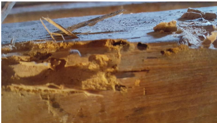
Č.39 – poškození dřevokazným hmyzem
