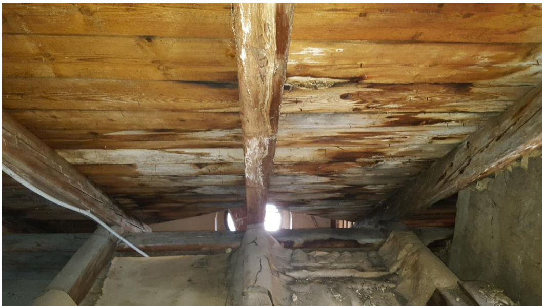
Č.29 – poškození zatékáním srážkové vody, dřevokaznými houbami, vlhkostí obsaženou v dřevní hmotě
