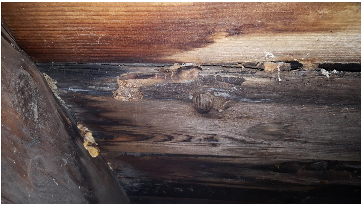
Č.59 – poškození dřevokaznou houbou, vlhkostí obsaženou v dřevní hmotě, zatékáním srážkové vody porušenou střešní krytinou
