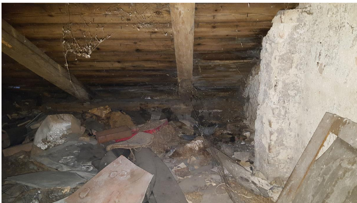
Č.49 – poškození zatékáním srážkové vody
