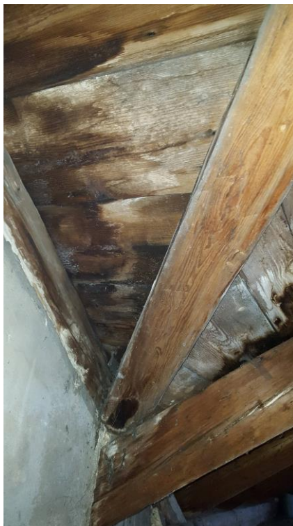
Č.32 – poškození zatékáním srážkové vody, dřevokaznými houbami či plísní
