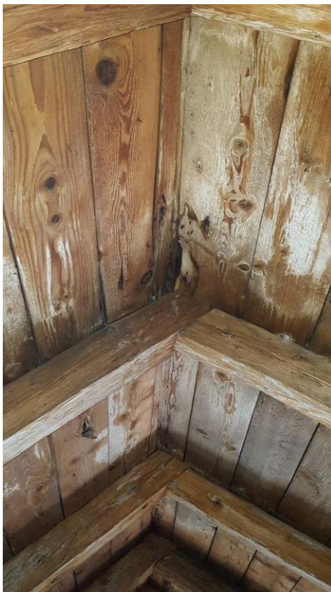
Č.44 – poškození zatékáním srážkové vody
