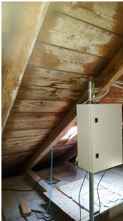
Č.10 – poškození zatékáním srážkové vody, plísní
