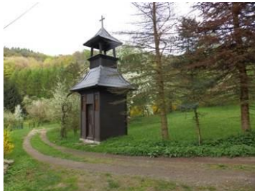
Obr. č. 42: Zvonice na Milířsku
