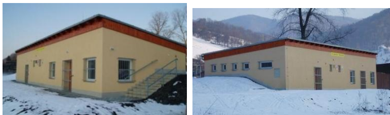
Obr. č. 26, 27, 28, 29 Fotbalové hřiště a nové kabiny se zázemím
