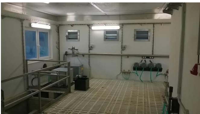
Obr. č. 37, 38, 39 Technická budova nově zbudované kanalizace a centrální ČOV
