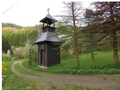
Obr. č. 42: Zvonice na Milířsku
